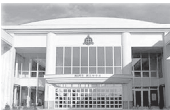
朝日中学校 校舎正面
